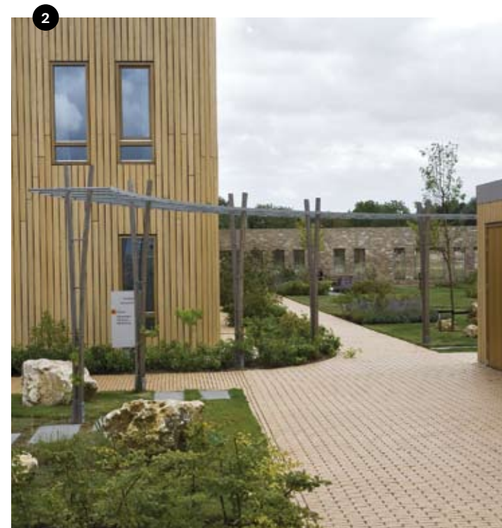
2 Op de splitsing van de twee tuinen is het levenspad de hoogte ingetild met een pergola ontworpen door Copijn. Het bestaat uit een v-vormige staander die door stalen dwarsbalken bijeen wordt gehouden. De maatvoering van de stalen ligger correspondeert met die van de natuurstenen stapstenen.
